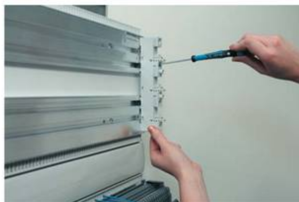
Schritt 4: Komponente ggf. ausrichten und einfach befestigen.
