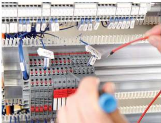
Schritt 1: Anschließen der Ader an der Komponente
