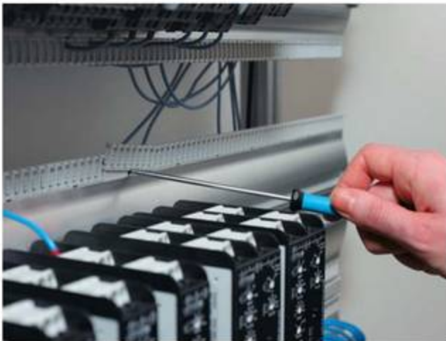
Schritt 1: Lösen der Kämme mit einem Schraubenzieher
