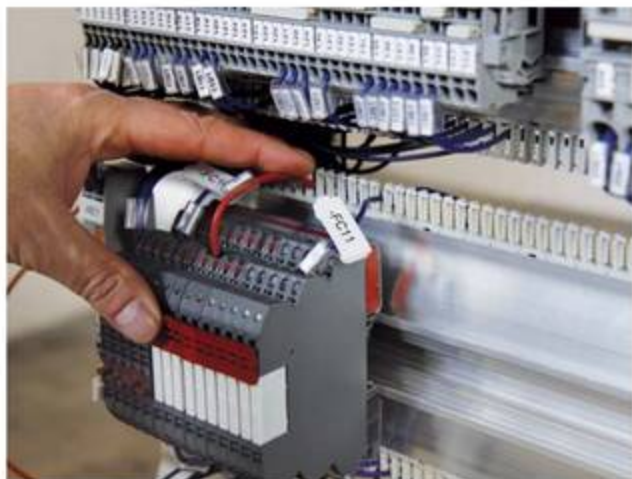
Verlegte Ader im Kammsegment
