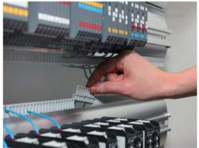
Schritt 2: Einfaches Entnehmen und Einsetzen der Kämme
